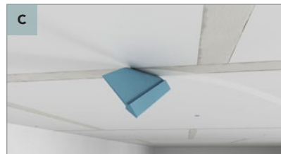
Täytä saumat, kiinnitä Rockfon Mono Acoustic Tape ja viimeistele saumat: Käytä haluamaasi työkalua sauman täyttämiseen.
