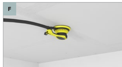
Hio saumat: Hio täytetyt saumat valitsemallasi työkalulla ja varmista, että saumat ovat täysin sileät.
