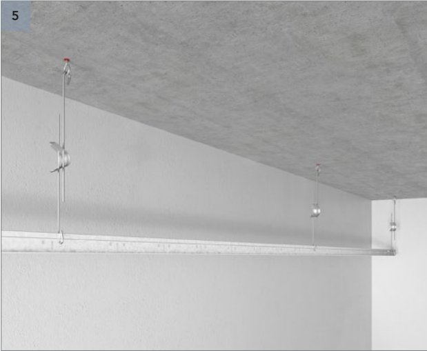
Kiinnitä pääkannatinlista T24 3600 pikakiinnikkeiden alaosaan. Muista varmistaa kiinnitys sulkemalla alempi koukku.
