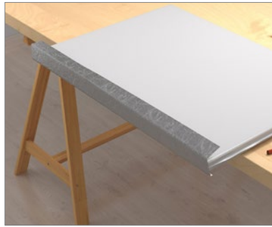
6. Taivuta ja paina pitkä sivu kiinni levyyn.
